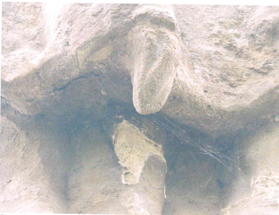
Kostomlaty n. Labem, socha sv. Jana Nepomuckého, detail hloubkové koroze kamene ve střední části sochy světce – stávající stav
