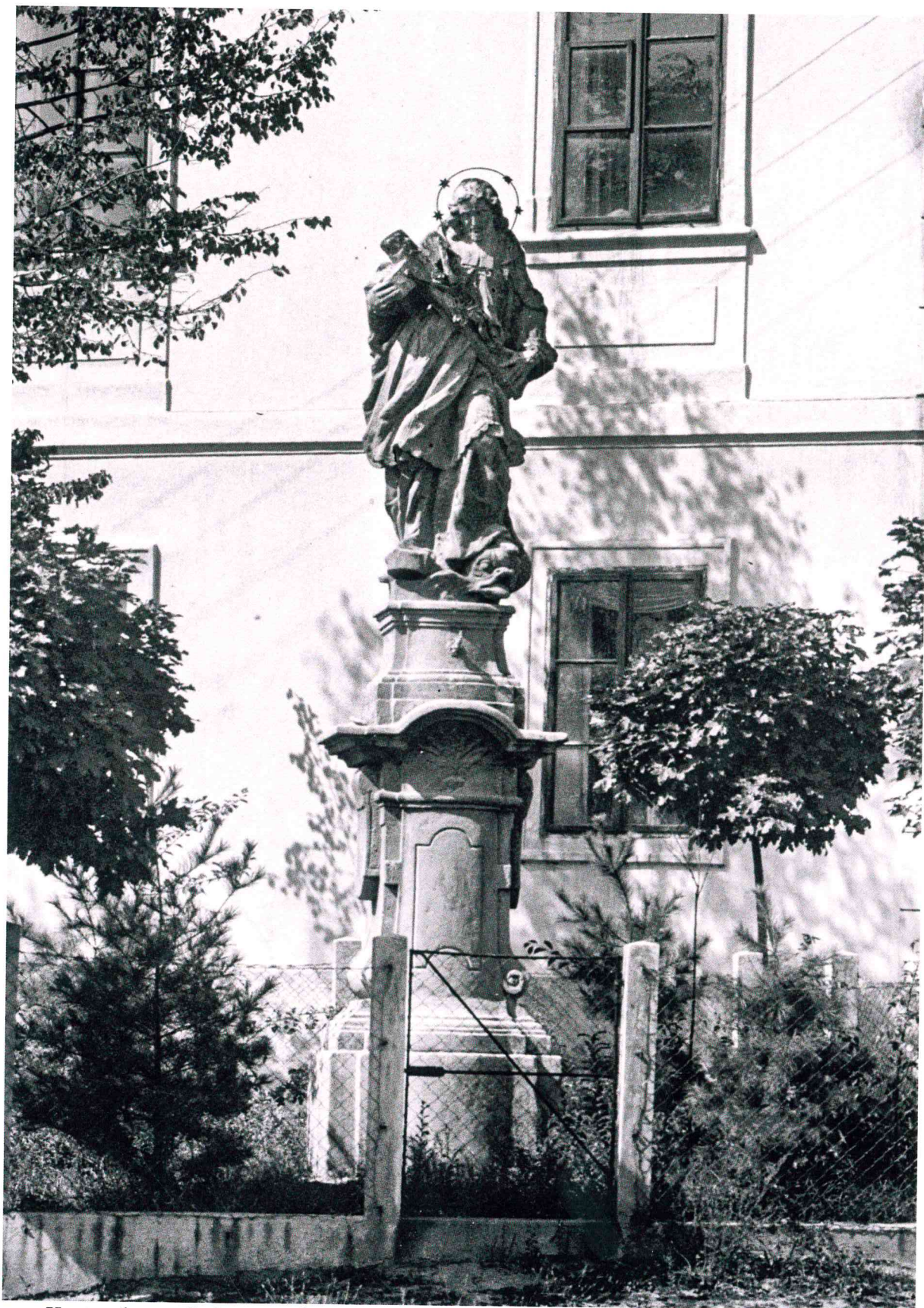
Kostomlaty n. Labem, socha sv. Jana Nepomuckého – historický snímek z roku 1953 zachycující sochu před poškozením v prostoru u staré školy
