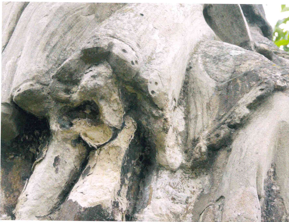
Kostomlaty n. Labem, socha sv. Jana Nepomuckého, detail hloubkové koroze kamene a modelačních doplňků ve střední části sochy světce – stávající stav
